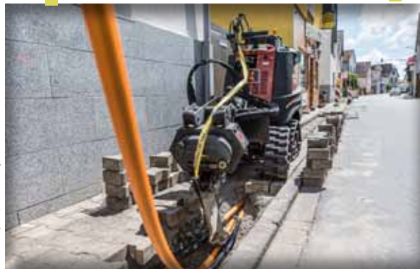
Die GGEW AG kann Leerrohr- und Glasfasertrassen mit dem modernen Vibrationseinzugsverfahren verlegen. Diese Methode beansprucht – wie hier in Bickenbach – nur wenig Platz und ermöglicht eine schnelle Fertigstellung.
