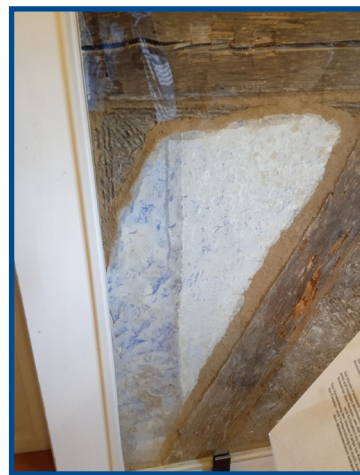
Freigelegter Wandputz im Büchnerhaus, mit blauer Farbe gestrichen zur Abweisung von Insekten. Küchenräume und Ställe, Tür- und Fensterrahmen wurden traditionell blau gestrichen, und die preiswerte Produktion künstlicher Blaufarben war ein großer Fortschritt.
