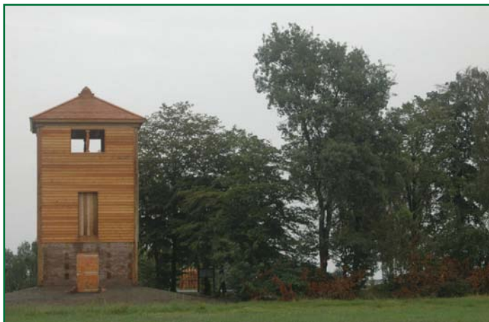
Der Limeswachturm WP 10/15 in Vielbrunn
